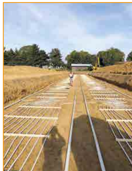
GPS-Einmessung des Energiefeldes.
