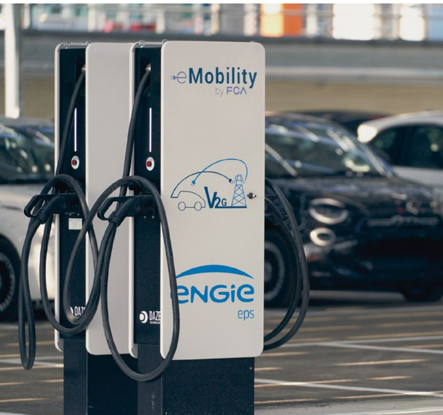
Bidirektionale Ladesäulen auf dem Werksgelände des FCA-Werks im italienischen Mirafiori
